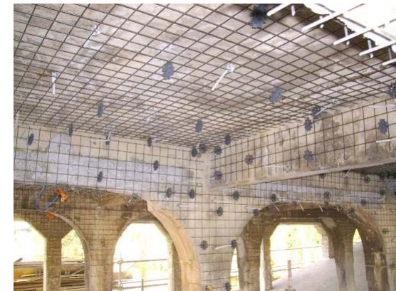
Ex : Traitement de réalcalinisation par CI du pont Camille de Hogues (86) – Novbéton® (Renofors)
